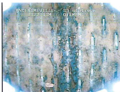
*Incrustation d'hydroxyde de fer de plus en plus dense pour se généraliser sur toute la crépine, colmatage partiel des ouvertures par ces mêmes dépôts ferriques plus ou moins indurés*
